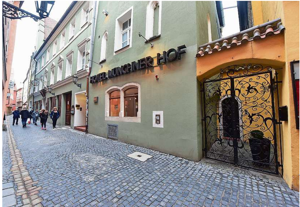
Das Hotel Münchner Hof in der Tändlergasse ist stolz auf seine mittelalterliche Bausubstanz. Der Dachstuhl ist original aus dem 14. Jahrhundert. Fotos: Lex
