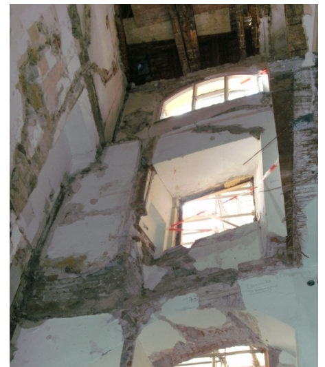
Kaum ein Stein bleibt: Das Gebäude wurde fast komplett entkernt
